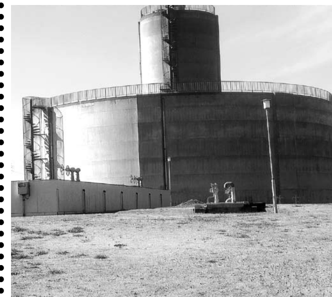
耐震診断の結果が出た築比地浄水場
