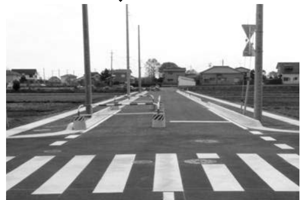
整備後（一部完成）
