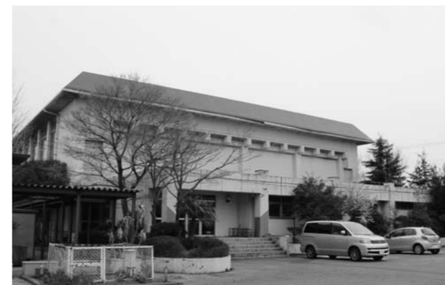
改修工事を待つ 松伏中学校体育館
