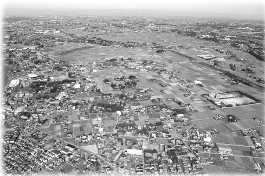
上空から見た松伏町の様子
