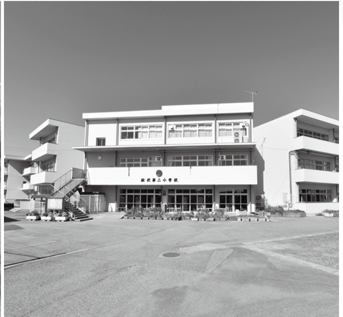
大規模改修された松伏第二小学校
