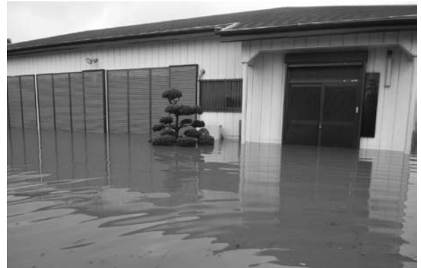
台風18号の豪雨により浸水した三栄会館
