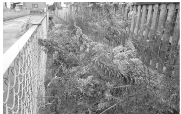
12月10日現在の保健センター裏排水路
