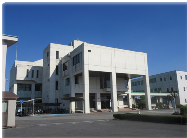
松伏町役場庁舎
