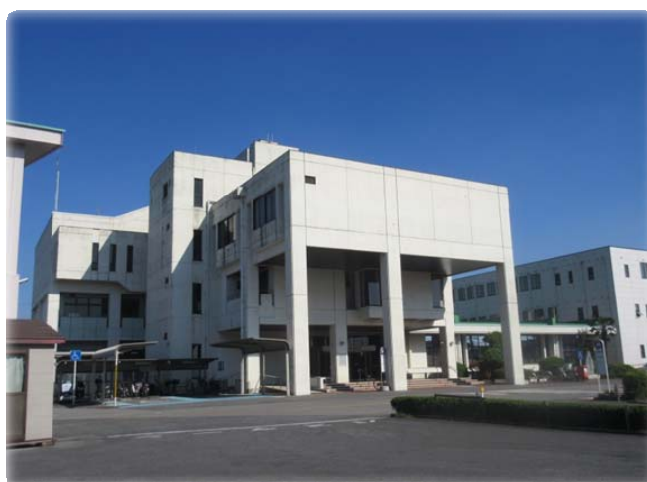
松伏町役場庁舎
