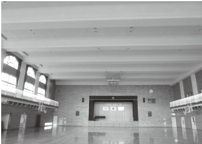
完成した第二小学校体育館吊り天井
