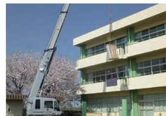
金杉小学校のエアコン設置工事の様子(室外機の搬入)
