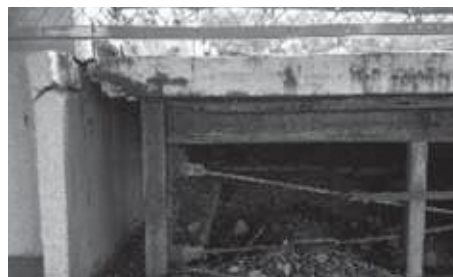
松伏中学校プール状況
