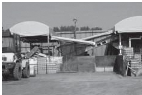
雨ざらしで修理を重ねている、中間処理場の機器
