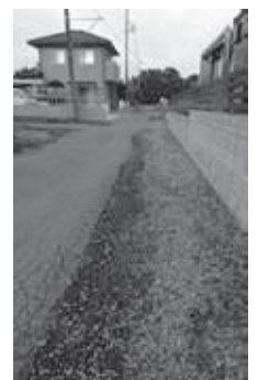
一部未舗装の町道 (金杉地内)
