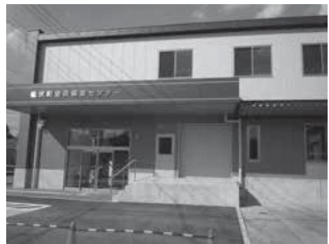
災害対策本部機能の代替施設「松伏町防災備蓄センター」
