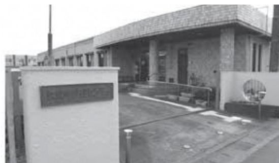
令和8年に建て替えが予定されている保健センター
