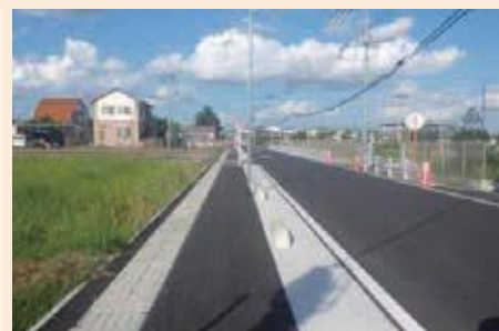
歩道が整備された町道3号線
