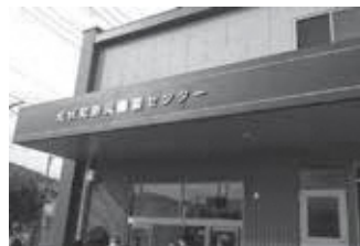
松伏町防災備蓄センター
