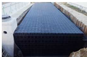
地下型貯留浸透槽
